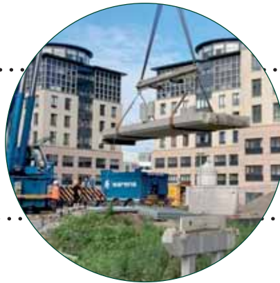
vakkundig ontmantelen betonnen bruggdelen
