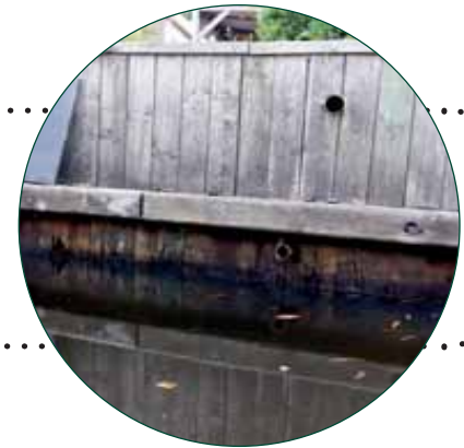
oogsten van houten damwanden nog goed onder de waterlijn
