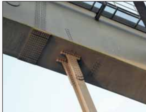
Liggers gelast en verbindingen gebout (1982)
