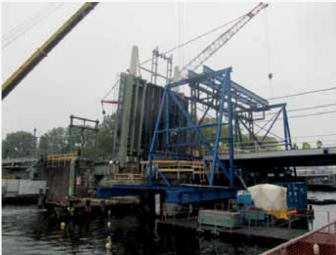
Vervangen pijler Spaarnebrug
