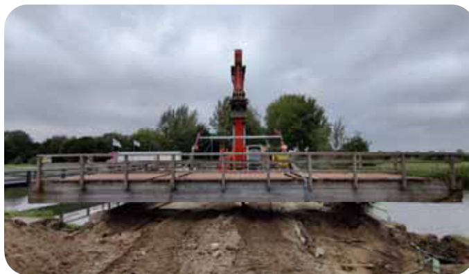
Hergebruik houten bruggen Zetten
