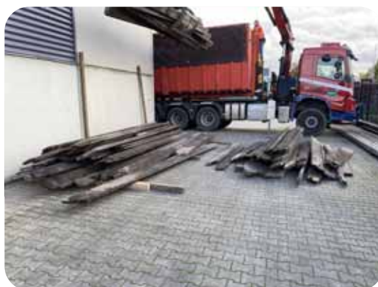
Hergebruik damwanden beschoeiing Zetten
