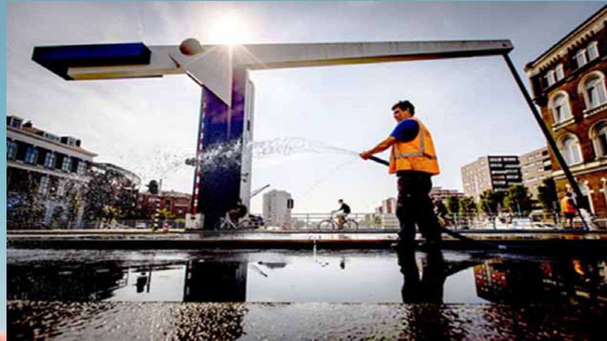
Referentiebeeld (Binnenhavenbrug Rotterdam AD, 2019)
