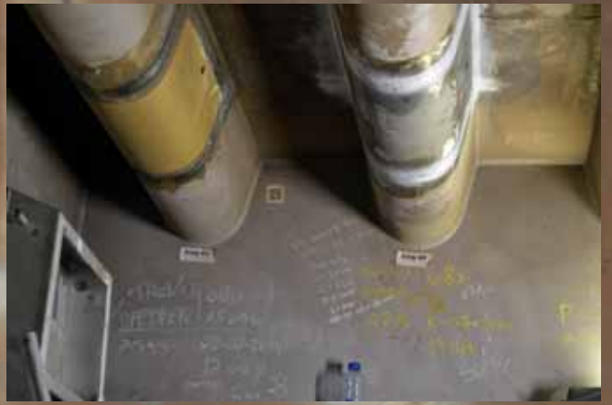
Een trogpasstuk onder het dek wordt vervangen.
