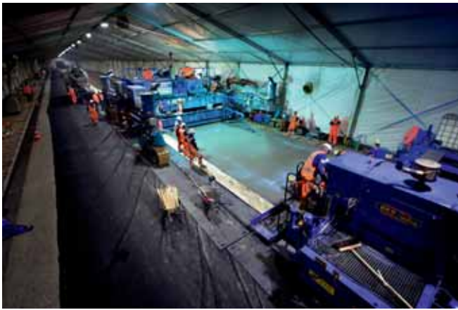
Met een slipformpaver wordt het HSB aangebracht.
