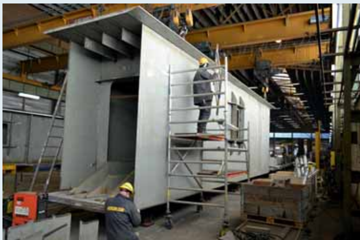
Productie van een sectie van een voorspanligger. © Galecom/WdH
