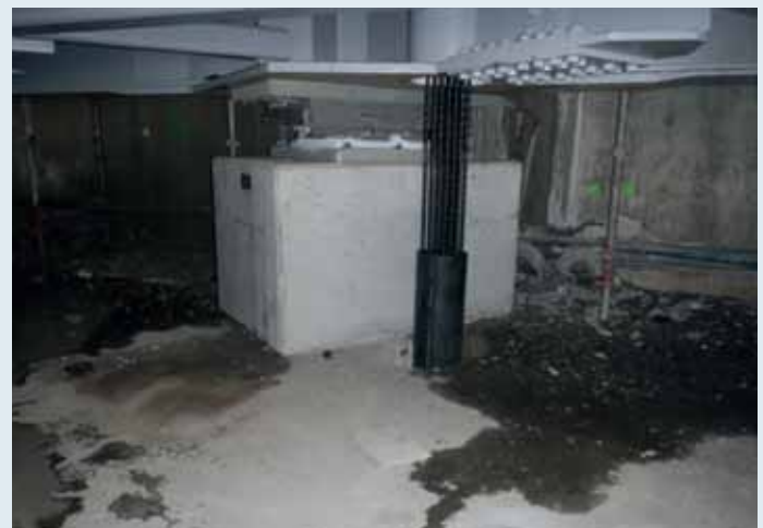
Een ligger wordt met vijzels op spanning gebracht en gaat mede de brug dragen. © Galecom/WdH
