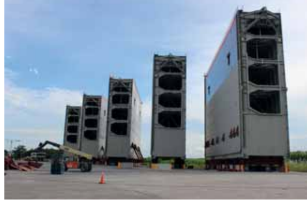
↑ 7 Vijf sluisdeuren gereed voor installatie in de sluis
