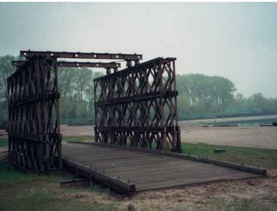
↑ Baileybrug proefopstelling.
