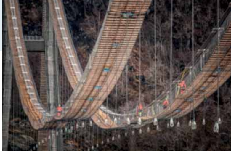
↑ Catwalk Dalsfjordbrug met hoofdkabels en hangers
