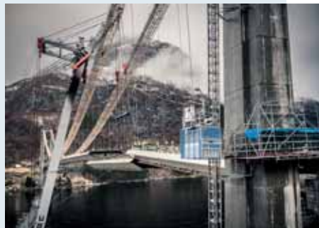
↑ Montage laatste segment
