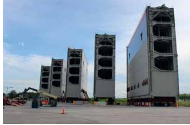
↑ 7 Vijf sluisdeuren gereed voor installatie in de sluis
