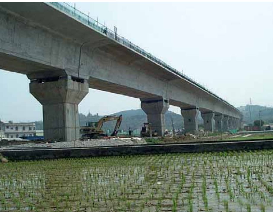
← Bruggenbouw in Maleisië.
