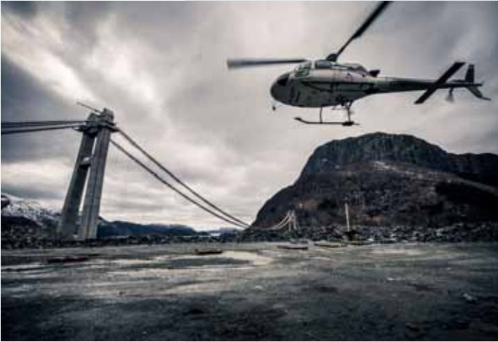
↑ Hangkabels worden met een helikopter gemonteerd
