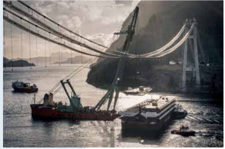
↑ Installatie met behulp van een drijvende kraan (sheerteg)
