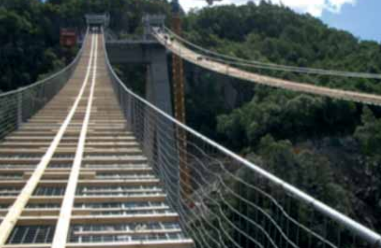
↑ Catwalk constructie
