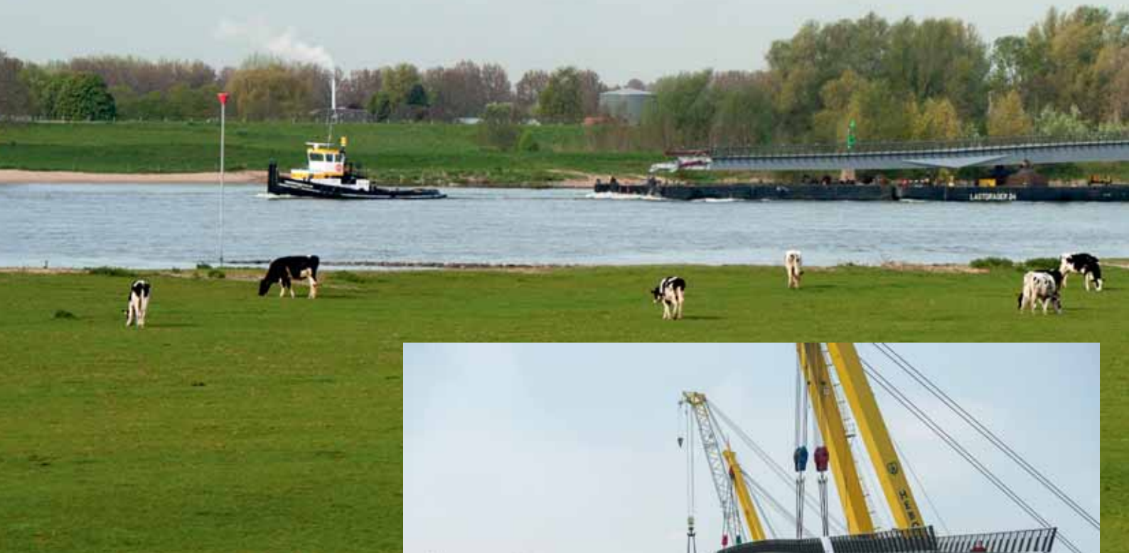
4 Transport Nieuwe Heemsteedsebrug over het water. HSM Steelstructures
