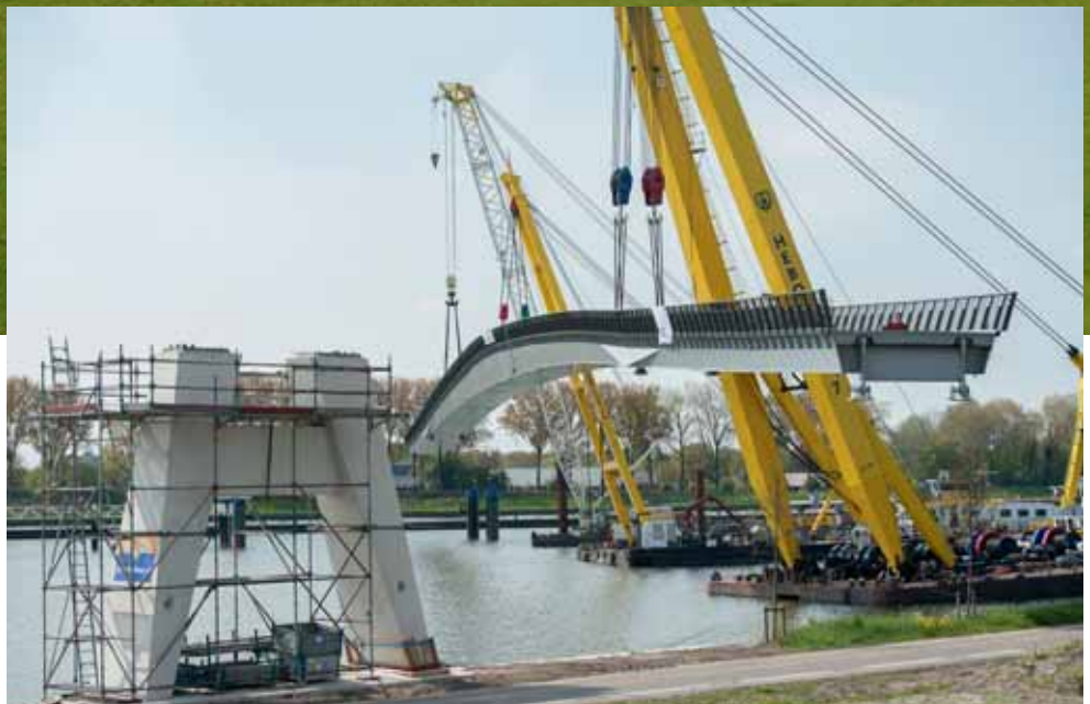
5a-b Plaatsing nieuwe brug op de landhoofden en pijlers. HSM Steelstructures
