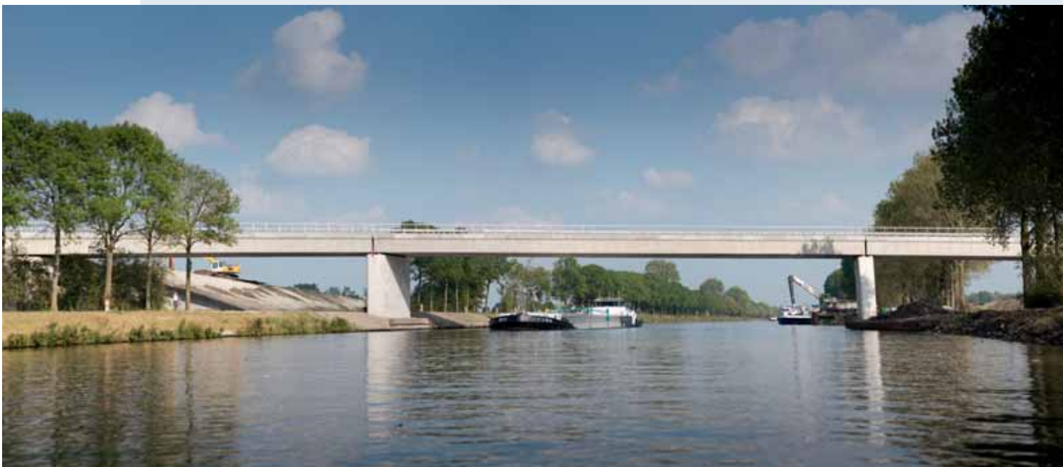
↑ Brug over het Van Starckenborgkanaal, Zuidhorn
