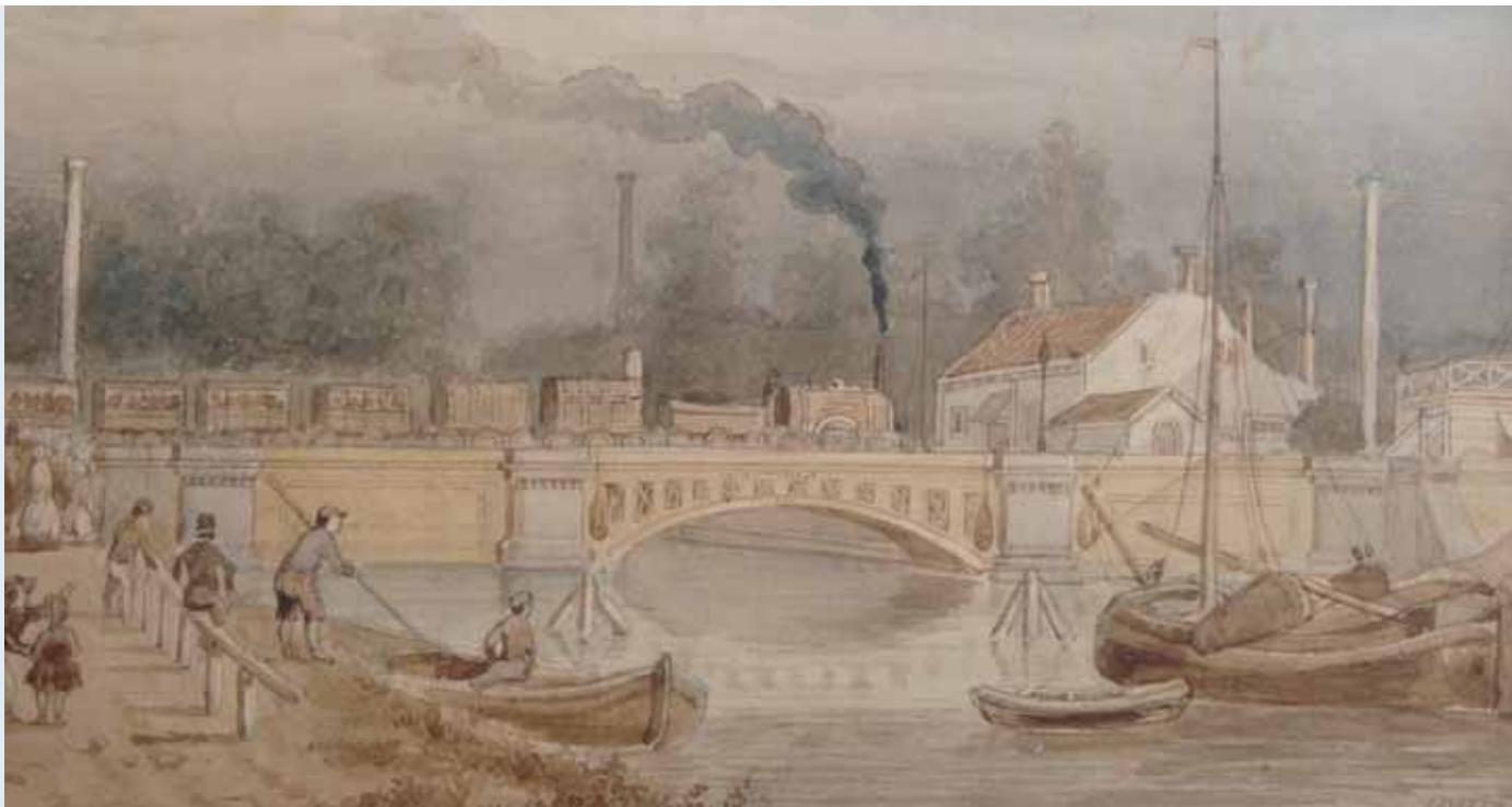
Draaibrug over de Haagvliet bij Den Haag
