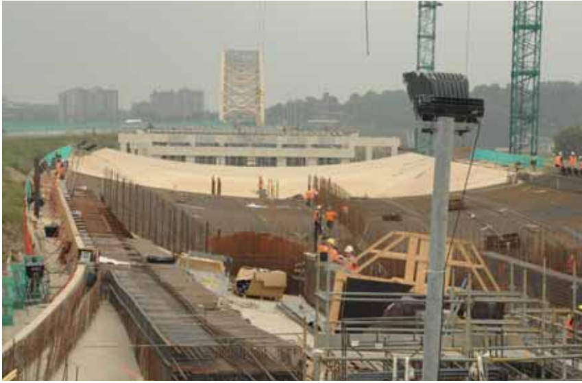
De bekisting voor de nieuwe aanbrug
