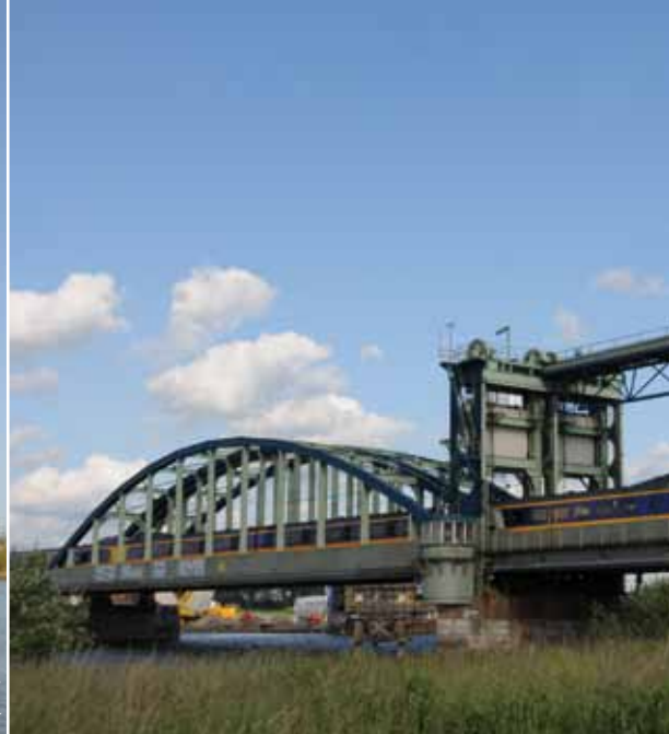
Door de lage ligging van de brug boven het water, moet de hefbrug geregeld worden geopend voor de scheepvaart. © G.J. Lujendijk
