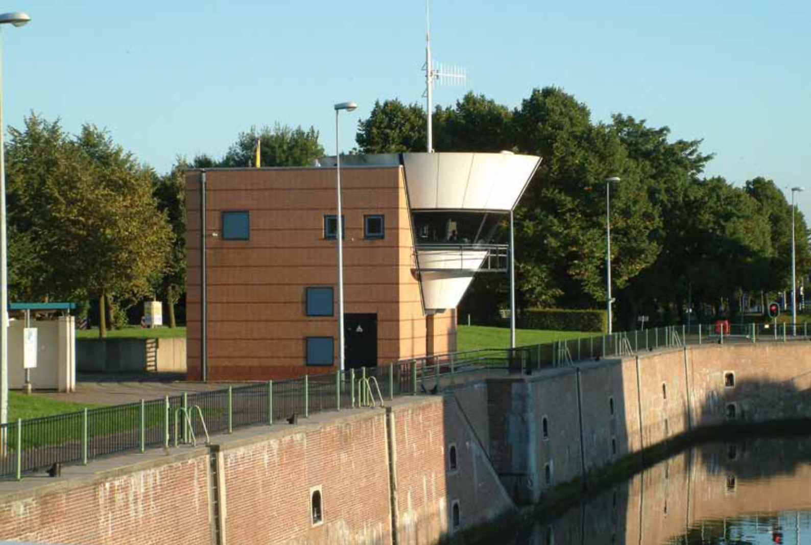
linksboven 4. Brugwachtershuisje bij de Wijkerbrug te Voorburg rechtsboven 5. Centrale bedieningspost voor de sluis te Vianen en bruggen over het Merwedekanaal.
