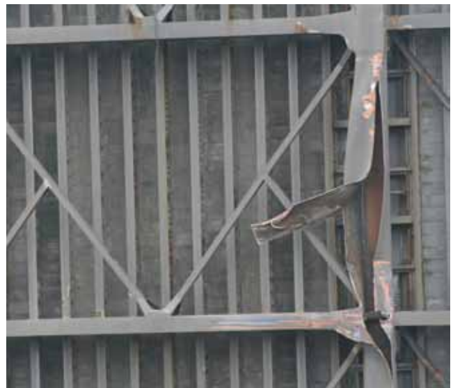
afb. 1 Schade na aanvaring
