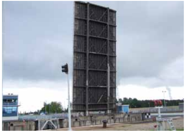
Tijdelijke balkconstructie aan hoofdligger
