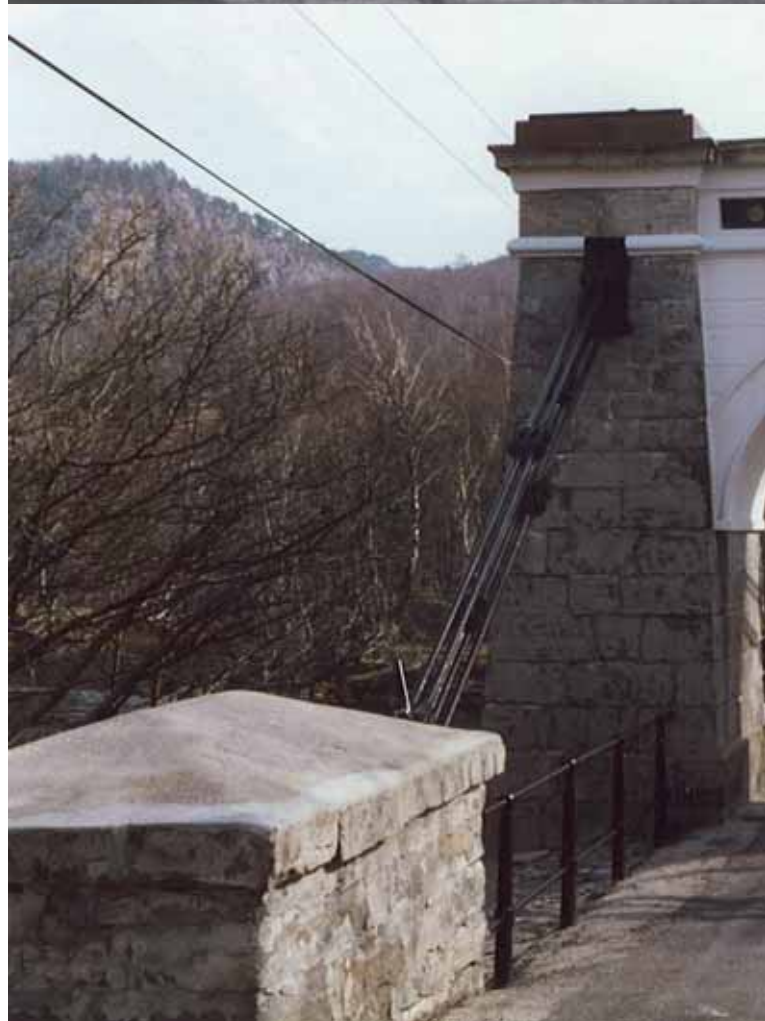
Afb.1 The High Coast bridge, verankering van de hoofdkabel (anchoring of main cable)
