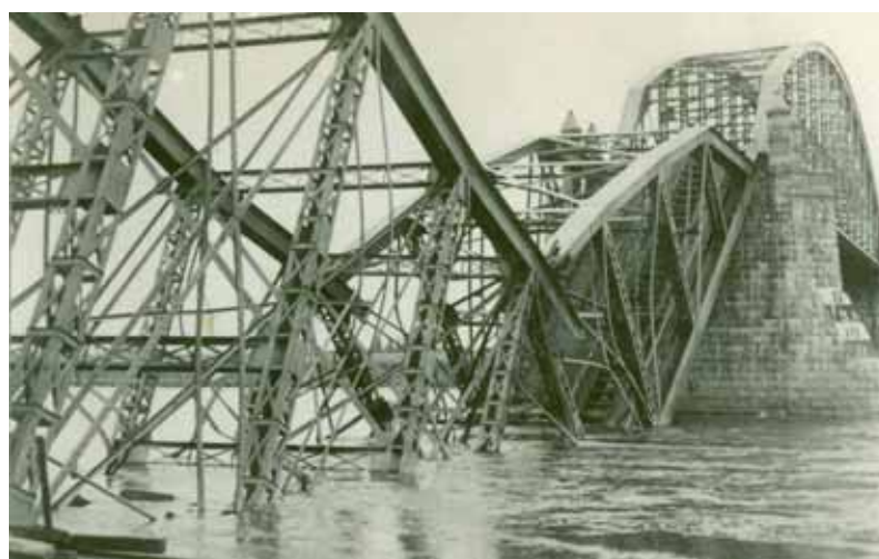
Vernielde overspanning in de spoorbrug bij Rhenen
