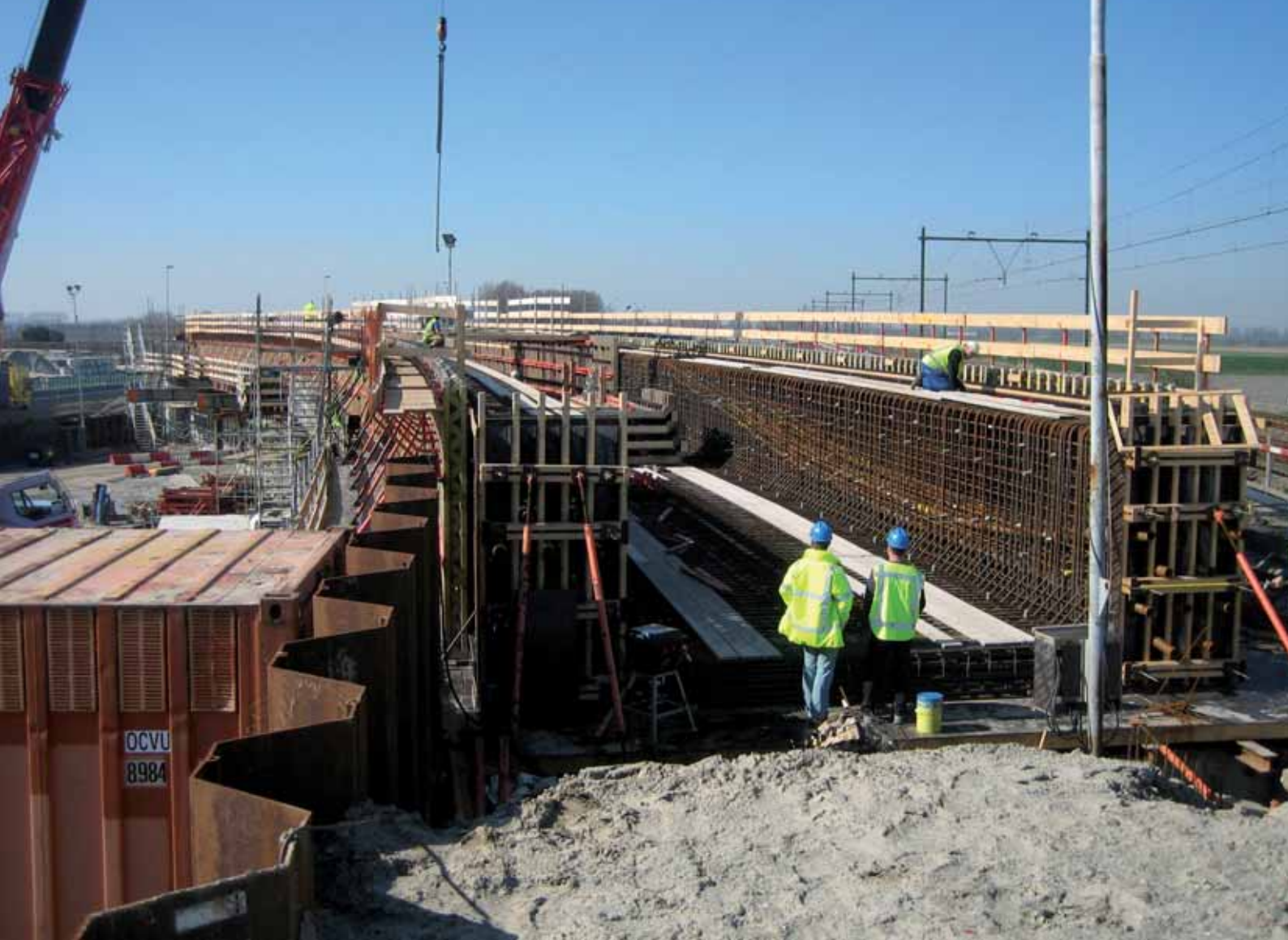
7. De trogbrug gezien vanaf het noordelijke landhoofd, waarbij de sterke kromming goed zichtbaar is.
