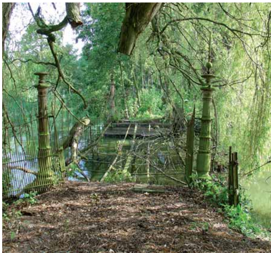
Hangbrug kasteel ter Wallen voor renovatie (foto Demeyere)
