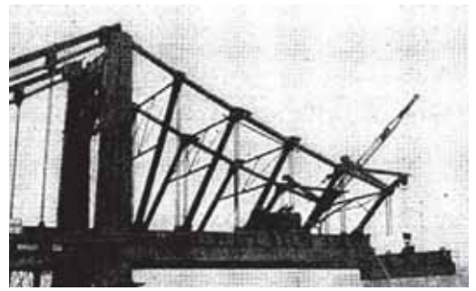
20. Bouw van een zelfverankerende hangbrug volgens de uitbouwmethode.
