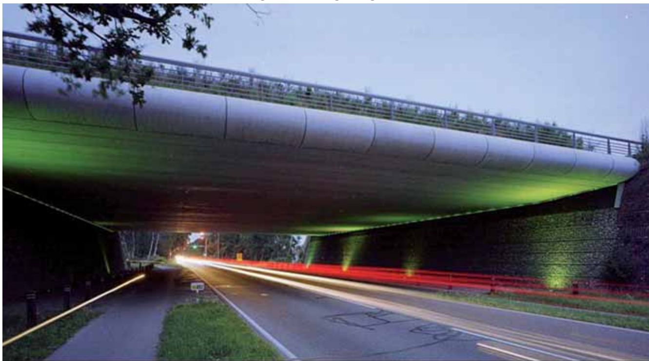
Natuurbrug Zanderij Crailoo, architecte ir. Beate Vlaanderen van het ingenieursbureau Arcadis
