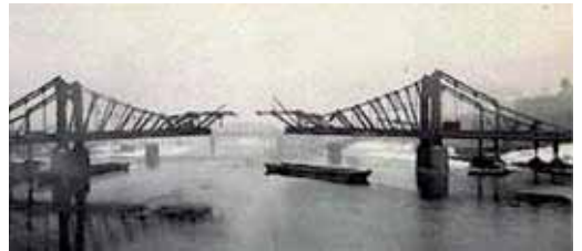
21. Uitbouwmethode onder toepassing van drukstaven.
