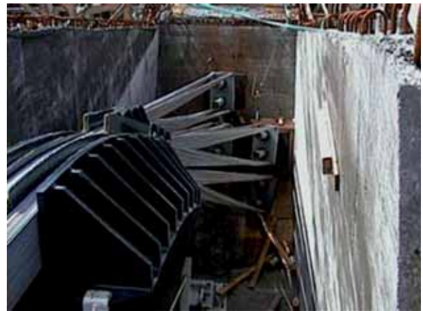
1. Voorbeeld van de aansluiting kabel – fundering (rotswand).
