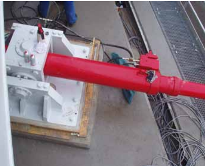
boven: Overzichtstekening Draaibrug linksonder: De bewegingscilinder van de nieuwe draaibrug
