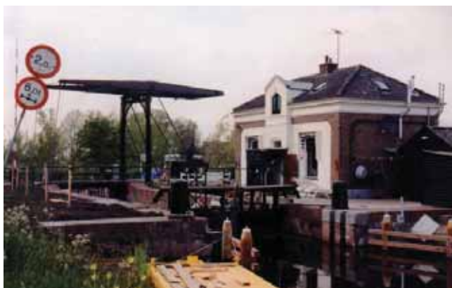
boven: De oplegging van de vaste betonbrug op de oostelijke kolkwand. Het metselwerk onder de brug is afgeboerd. midden: De vaste betonbrug over de Stolwijker Schutsluis met op de voorgrond het bewegingswerk voor de binnenschuif in het omloopriool tussen de kolk en het buitenhoofd. (herfst 2004)
