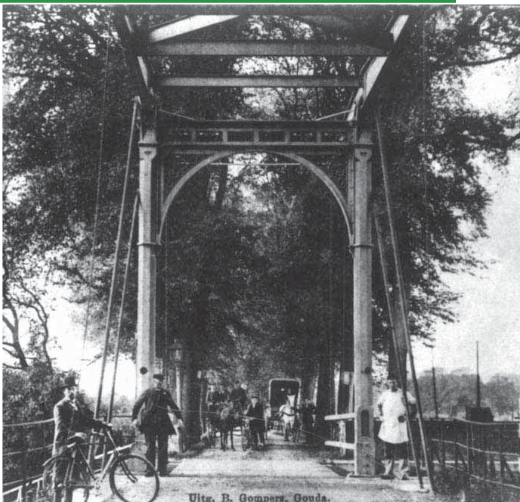
De ijzeren ophaalbrug uit 1888 over de Stolwijker Schutsluis aan het begin van de twintigste eeuw.
