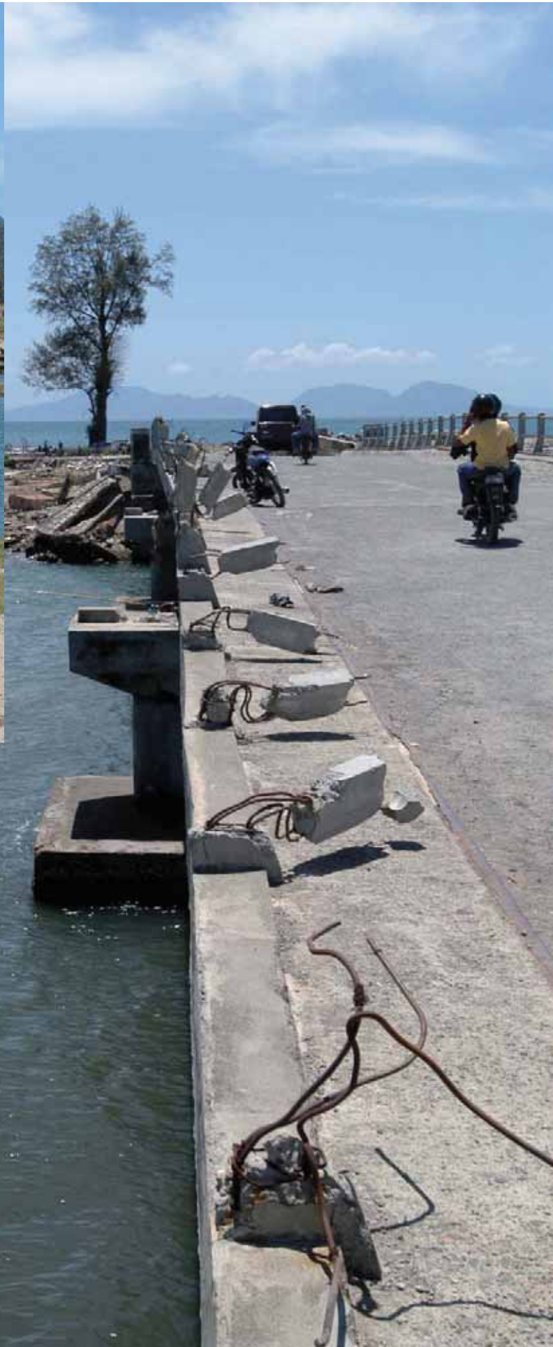
Betonnen brug verschoven door het water.
