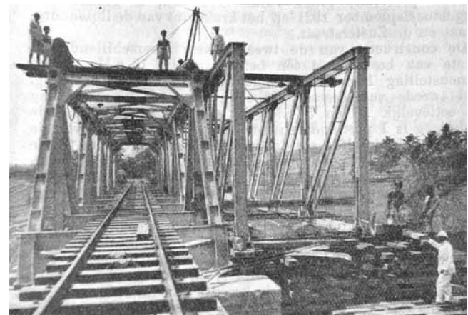
20. Demontage van een brug van 45 m.
