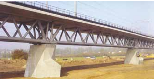
Staalbetonbrug bij Oosterbeek over de uiterwaarden
