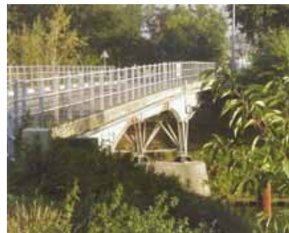
De oude trambrug over het kanaal Wessem-Nederweert (foto: Dienstkring Waterwegen Roermond)
