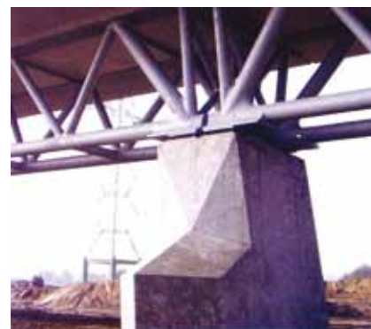
Detail van brug bij Oosterbeek
