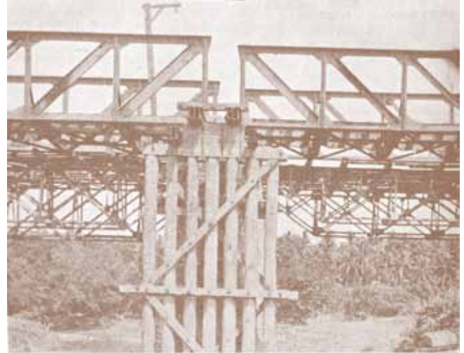
Twee opnames van één van de pijlers mt de tijdelijke brugopleggingen. Tegen de pijler de houten hulpjukken. De (de)montagebruggen zijn al onder de oude bruggen geschoven.
