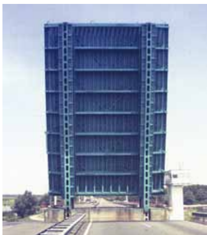
De Haringvlietbrug krijgt als eerste grote brug in Nederland een aluminium rijdek
