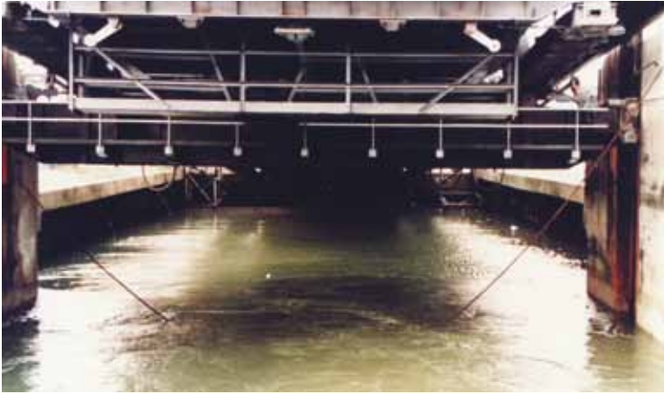
De hijsligger (Foto Bouwdienst Rijkswaterstaat)
