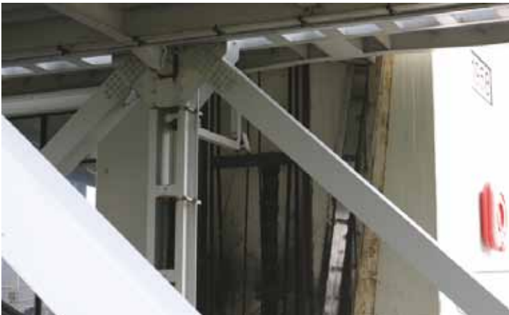
Geleiding langs de heftorens. De getrapte rail voor de noodsteunen. (foto Ciska Klooster)
