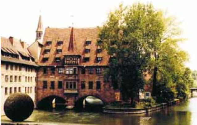
Afb. 4. Voorbeeld van een hospitaalbrug te Nürnberg.
