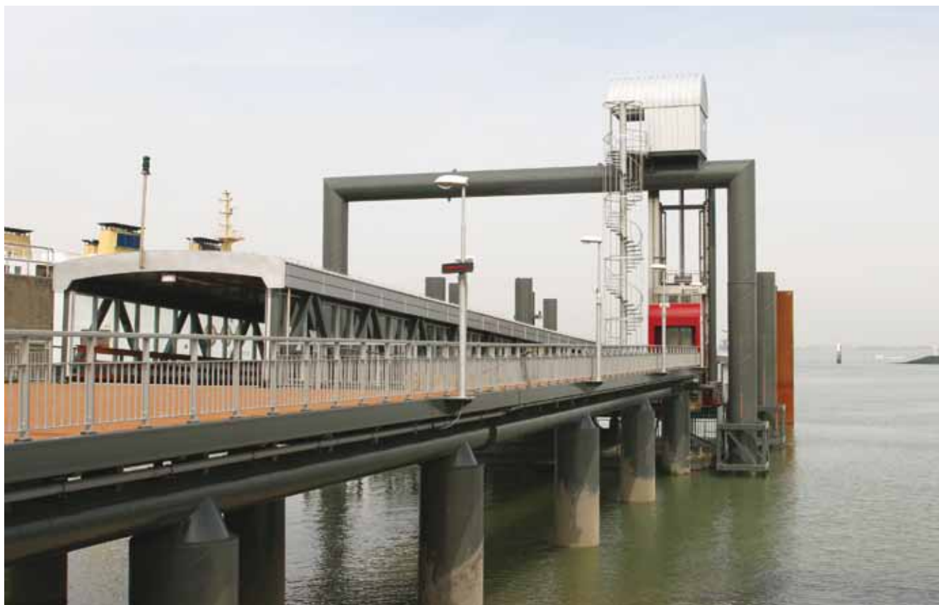
Nieuwe aanleginrichting. De lift kan worden gebruikt bij zeer hoog of zeer laag water, als de helling van de anlegbrug te steil wordt voor de rolstoelgebruikers (foto Ciska Klooster)
