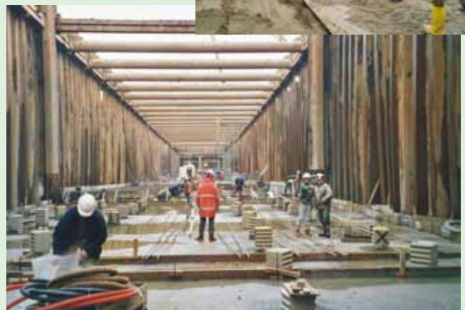
Bezoek aanleg HSL-tunnel te Rotterdam (foto:H.J.J. Roelofs)
