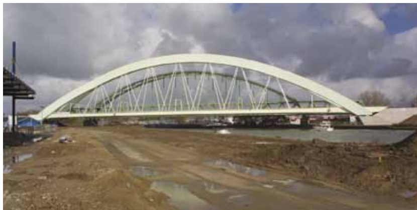
Figuur 12. Demka spoorbrug Amsterdam-Rijnkanaal Utrecht. Karakteristieken: diagonaal hangerconfiguratie; hangers uitgevoerd als buisprofiel; geen boven(wind)verband
