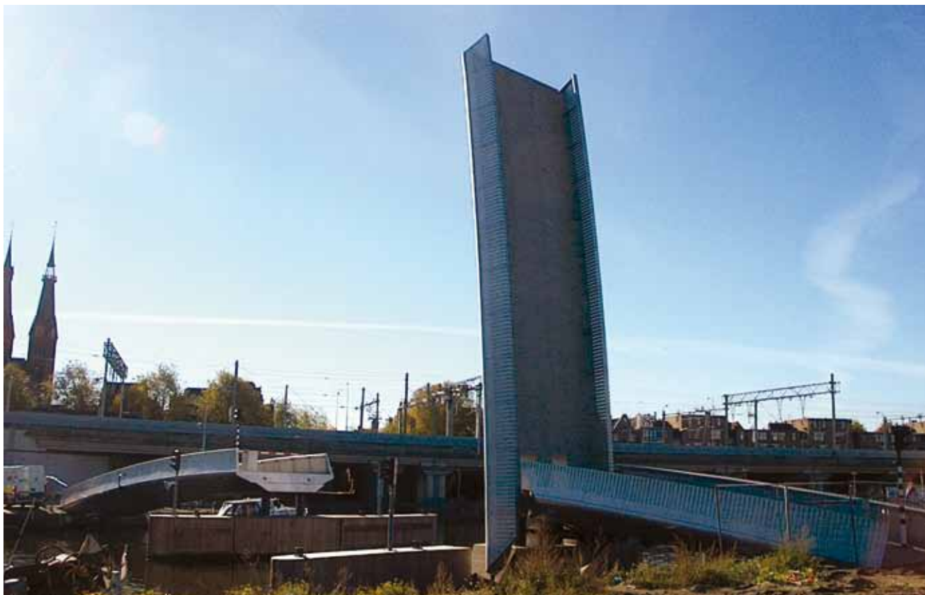
De fiets- en voetgangersbrug Westerdokssluis
