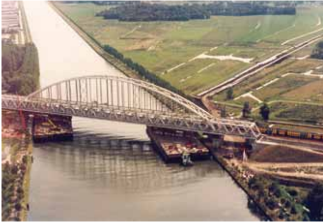
5. Muiderspoorbrug over het Amsterdam-Rijnkanaal bij Weesp.
