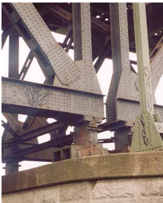
9. Klassieke oplegging toegepast bij de spoorbrug Oosterbeek links boven: oplegging hoofdoverspanning links onder: oplegging aanbrug op pijler rechts boven: oplegging aanbrug op landhoofd rechts onder: totaaloverzicht van de brug
