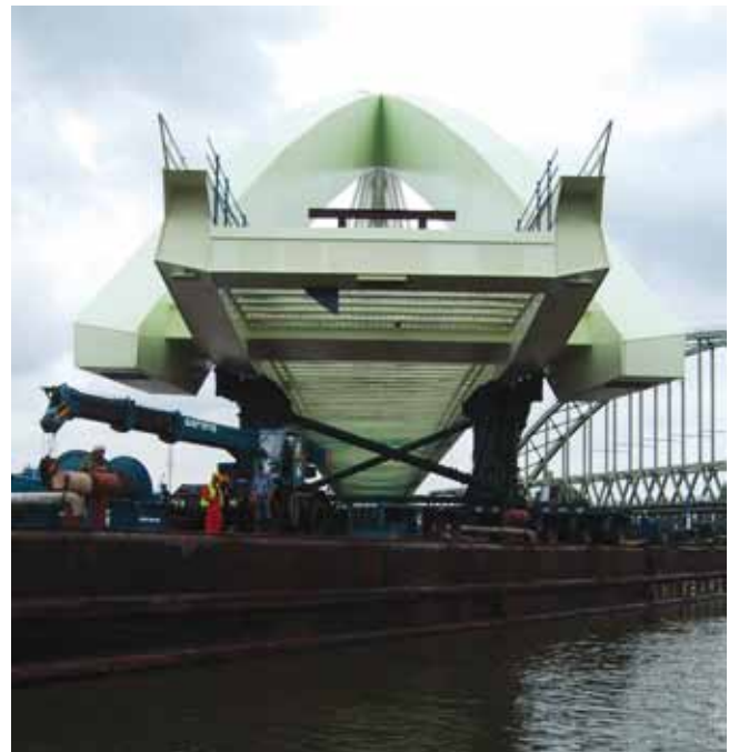
1. Invaren van de Werkspoorbrug.
