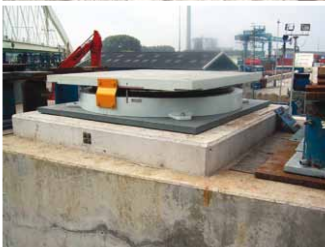
3. Werkspoorbrug: van boven naar beneden: Overzicht werkspoorbrug, landhoofd, oplegging van de boog, detail van potoplegging van de boog.
