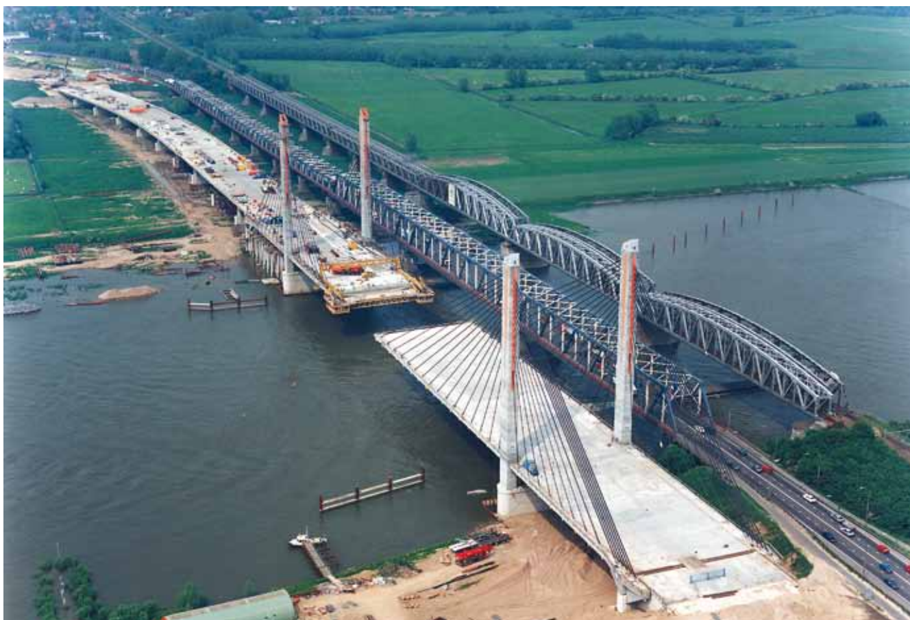
Drie bruggen over de Waal bij Zaltbommel.
