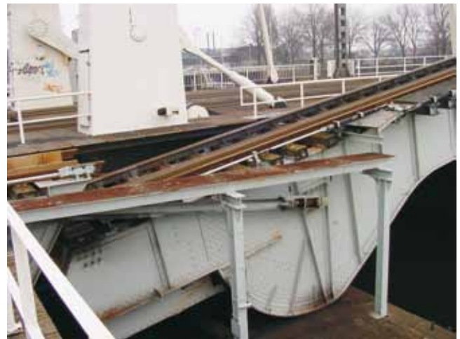
Aan de trekstang wordt de rolbasculebrug opengetrokken.
