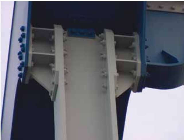
Detail van de brug bij Vlakte
