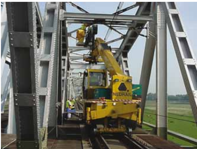
Inspectie spoorbrug bij Hedel
