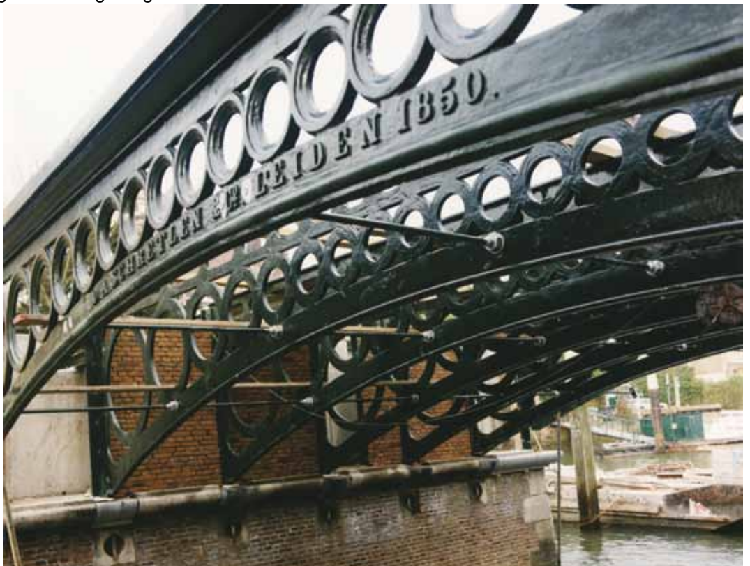
Gietijzeren liggers van de Nieuwbrug.
