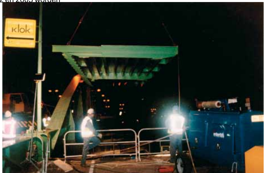
Aanbrengen nieuwe stalen voetpad
