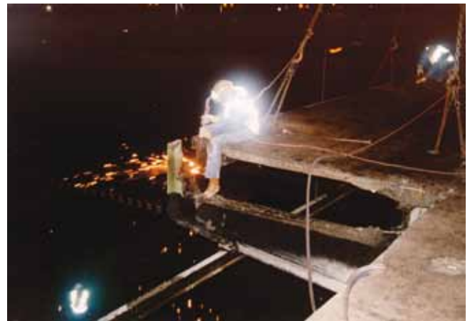
Slopen betonnen voetpad
