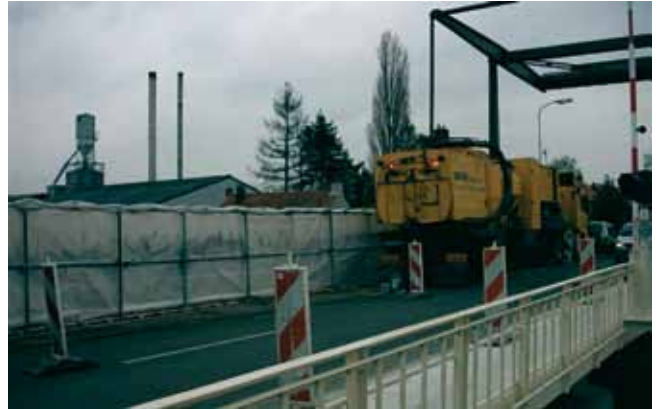
De brug wordt ingepakt om hem te kunnen metalliseren
