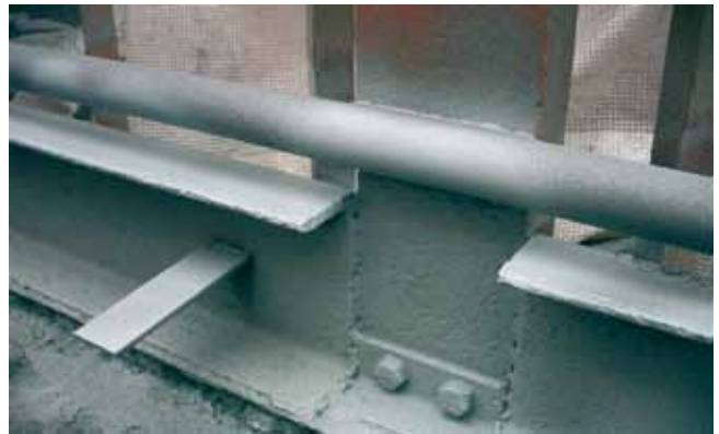
De brug is geconserveerd met een aluminiumlaag
