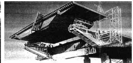
Figuur 12. Assemblage hoofdliggers Dintelhaven spoorbrug. (links) Figuur 13. Plaatsing van een brugsectie met uitbouwwagen; Ewijk. (boven)
